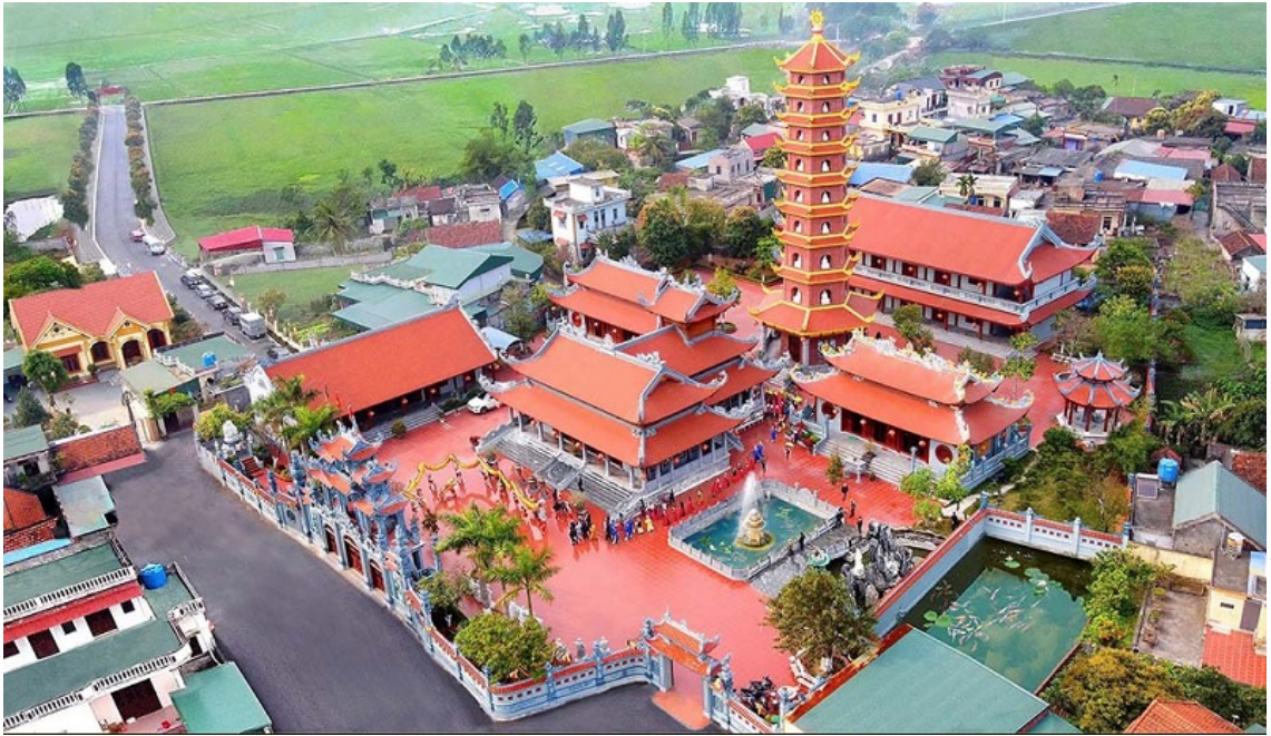
Chùa Linh Ứng sau khi hoàn thành 21 hạng mục công trình
